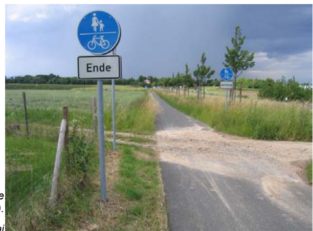
Benutzungspflichtiger Zweirichtungsweg der Kreisstraße K 786 zwischen Hofheim und Kelkheim (Main-Taunus-Kreis/D).
